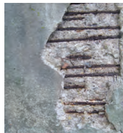
Abb. 2: Stahlkorrosion
