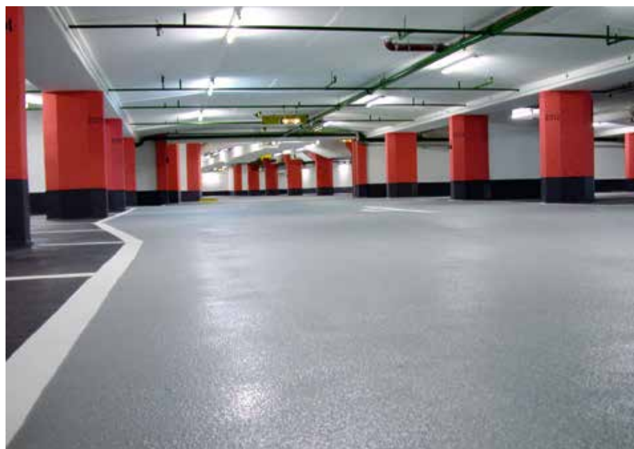
Boden versiegelt mit Polyurethanharzen
