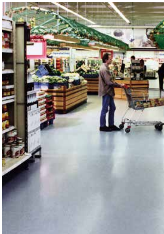
MMA-Bodenbeschichtung in einem Supermarkt
