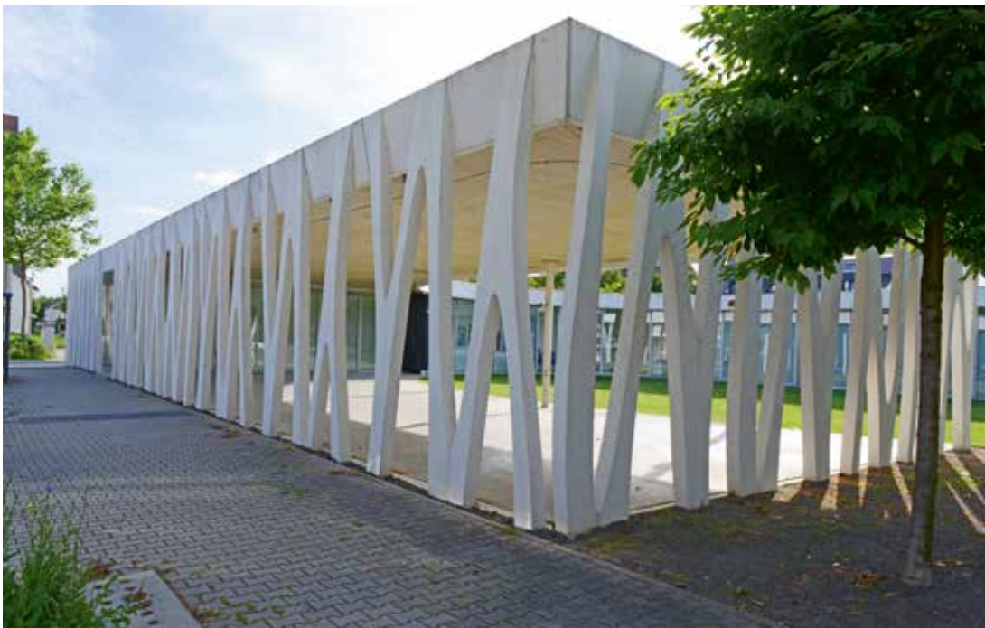
Selbstverdichtender Beton, Gemeindezentrum Mannheim
