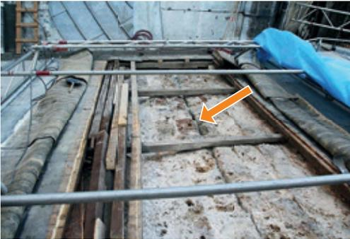
Erdbebenriss vor dem Aufbringen eines Klammerpflasters aus Mörtel und Carbonbewehrung
